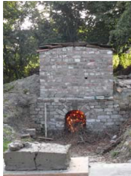
De replica van een permanente steenoven in Aduard. Op de voorgrond een steen die tijdens het droogproces is gebarsten.
